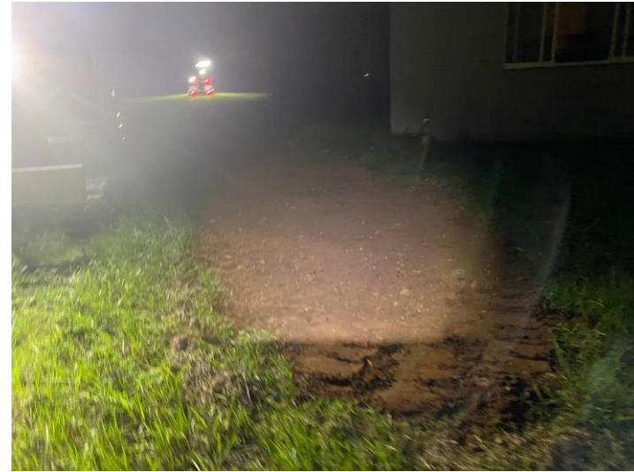
新待命點建築旁凹坑填補 (改善後)圖-12
