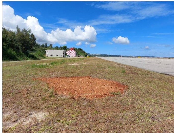
新待命點附近凹坑填補 (改善後)圖-6
