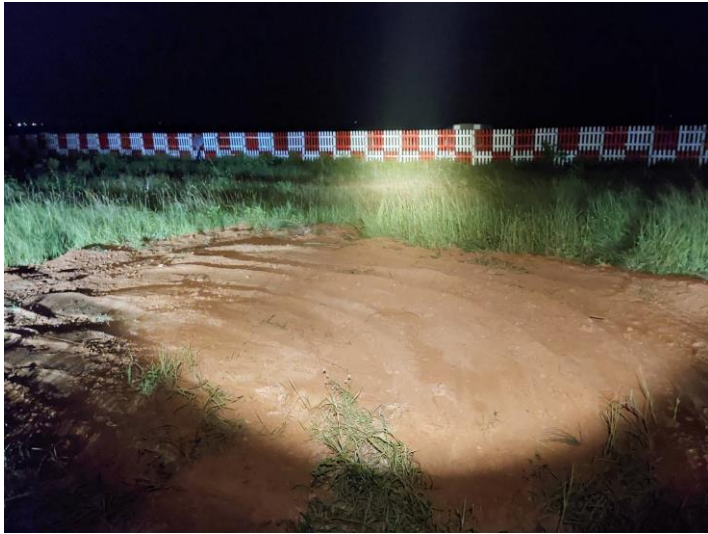
24 跑道頭凹坑填補 (改善後)圖-9
