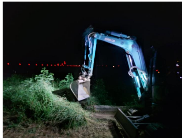
24 跑道頭凹坑填補 (改善中)圖-8
