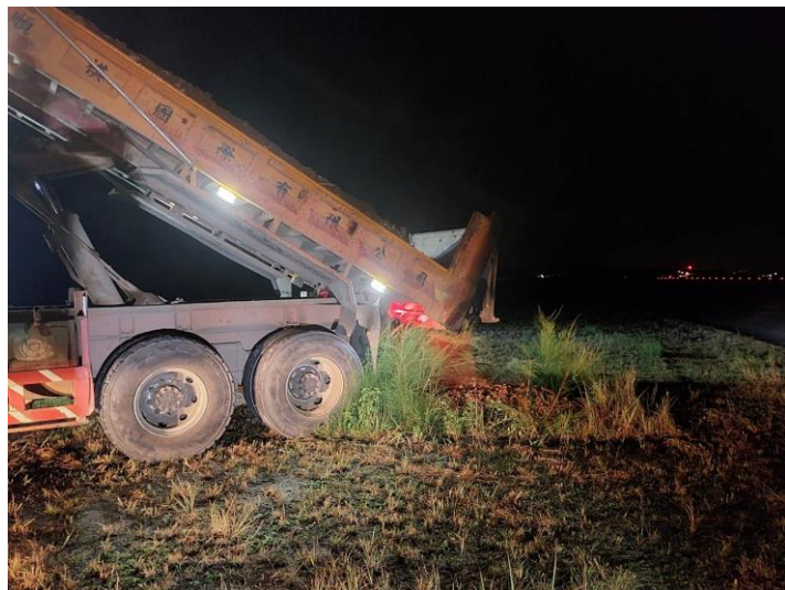
新待命點附近凹坑填補 (改善中)圖-5
