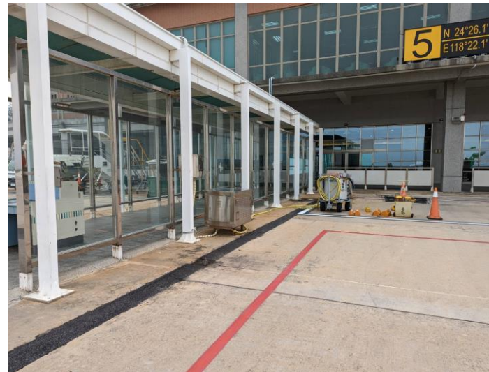
4、5、6 停機坪上設置之自動航機引導機電箱移除(改善後)圖-4
