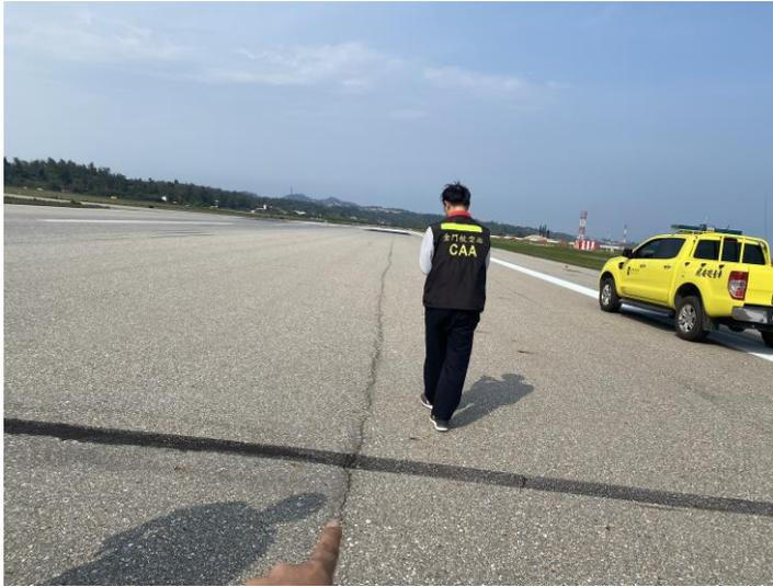
B 及 C 滑行道間-跑道道面縱向裂縫約 100 尺
