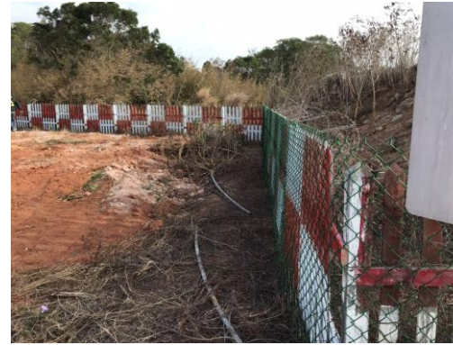
后湖砲陣地新作圍籬延伸(改善後)圖-4
