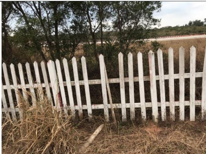
KNH-2019-0042、圖-7 近期圍籬檢視(修復前)
