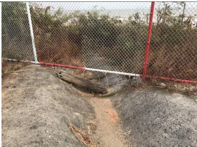
KNH-2019-0042、圖-5 近期圍籬檢視(修復前)
