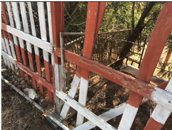
KNH-2019-0042、圖-1 近期圍籬檢視(修復前)
