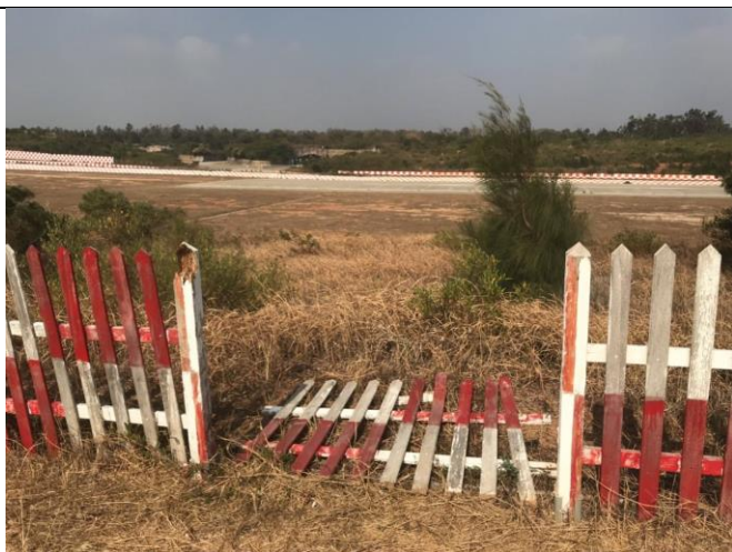
KNH-2019-0042、圖-3 近期圍籬檢視(修復前)
