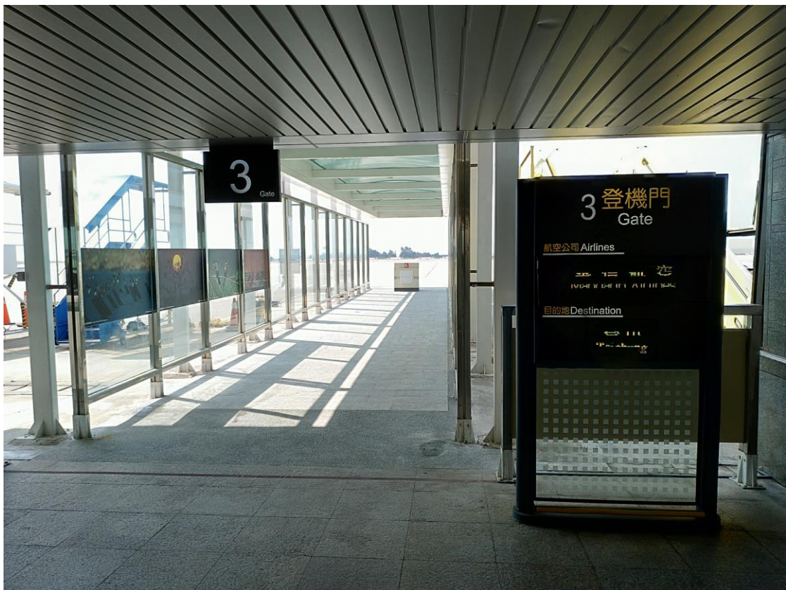
圖 2017-0042-2、3 號風雨走廊道面現況，道面坑洞改善完畢
