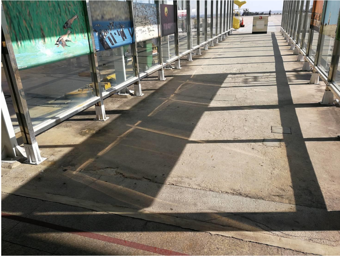
圖 2017-0042-1、3 號風雨走廊道面坑洞
