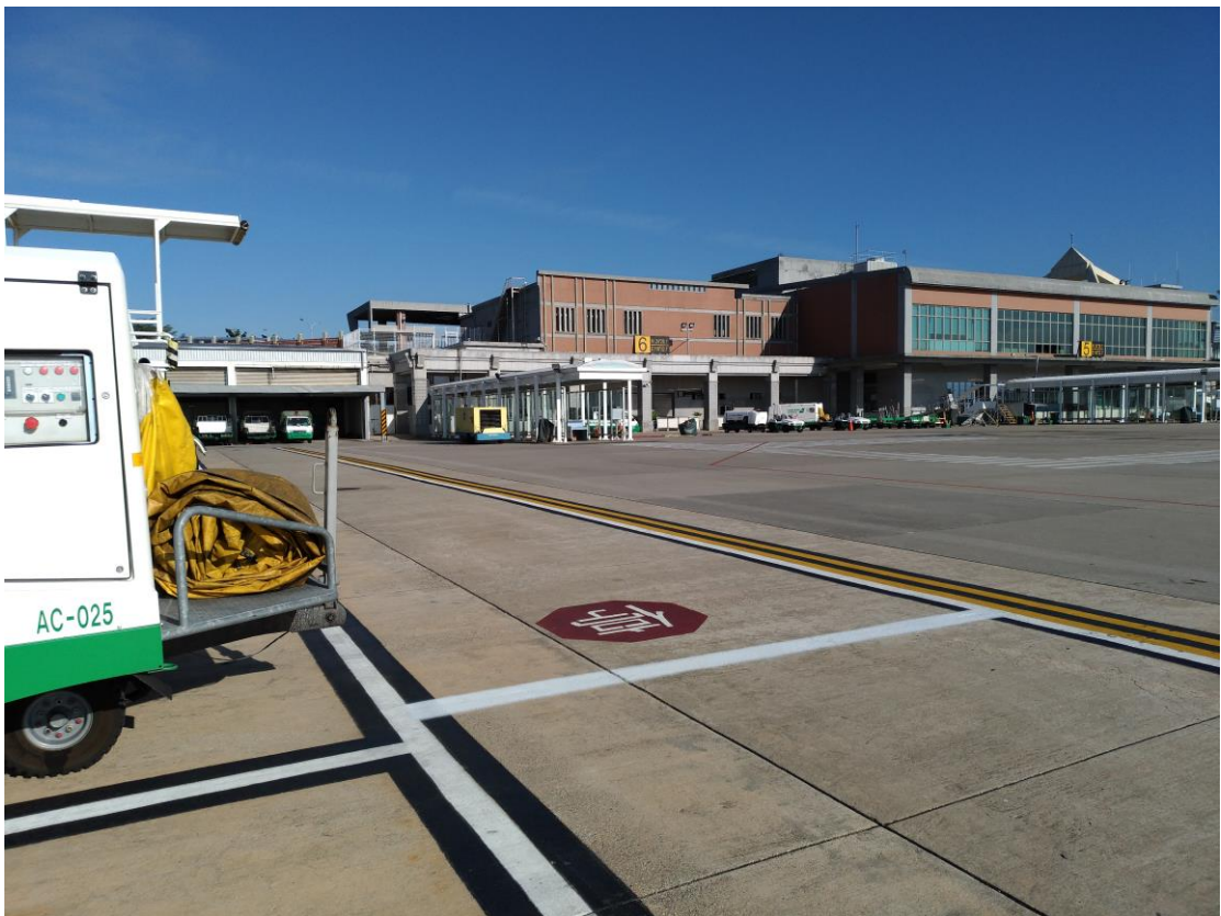
圖 2018-0004-2、6 號停機坪旁交通道之停止線
