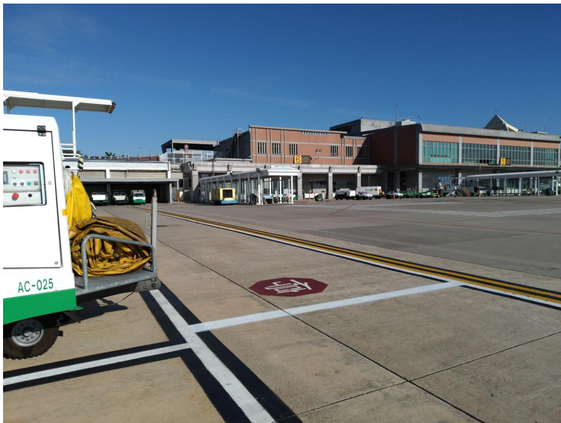
圖 2017-0038-1、6 號停機坪旁磨除 3 個停車格並加設停止線
