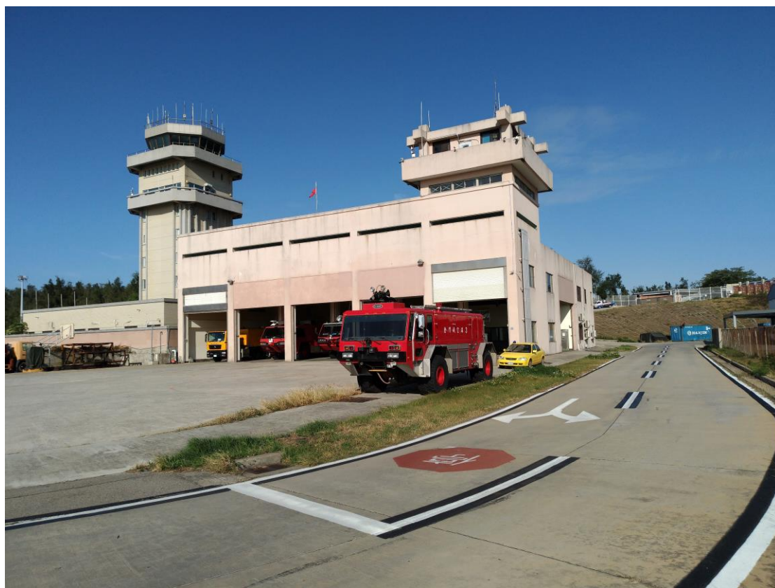
圖 2017-0038-2、消防班旁停止線
