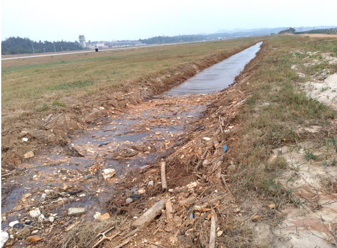
圖 2017-0036-2、海側環場道海漂垃圾清除完畢
