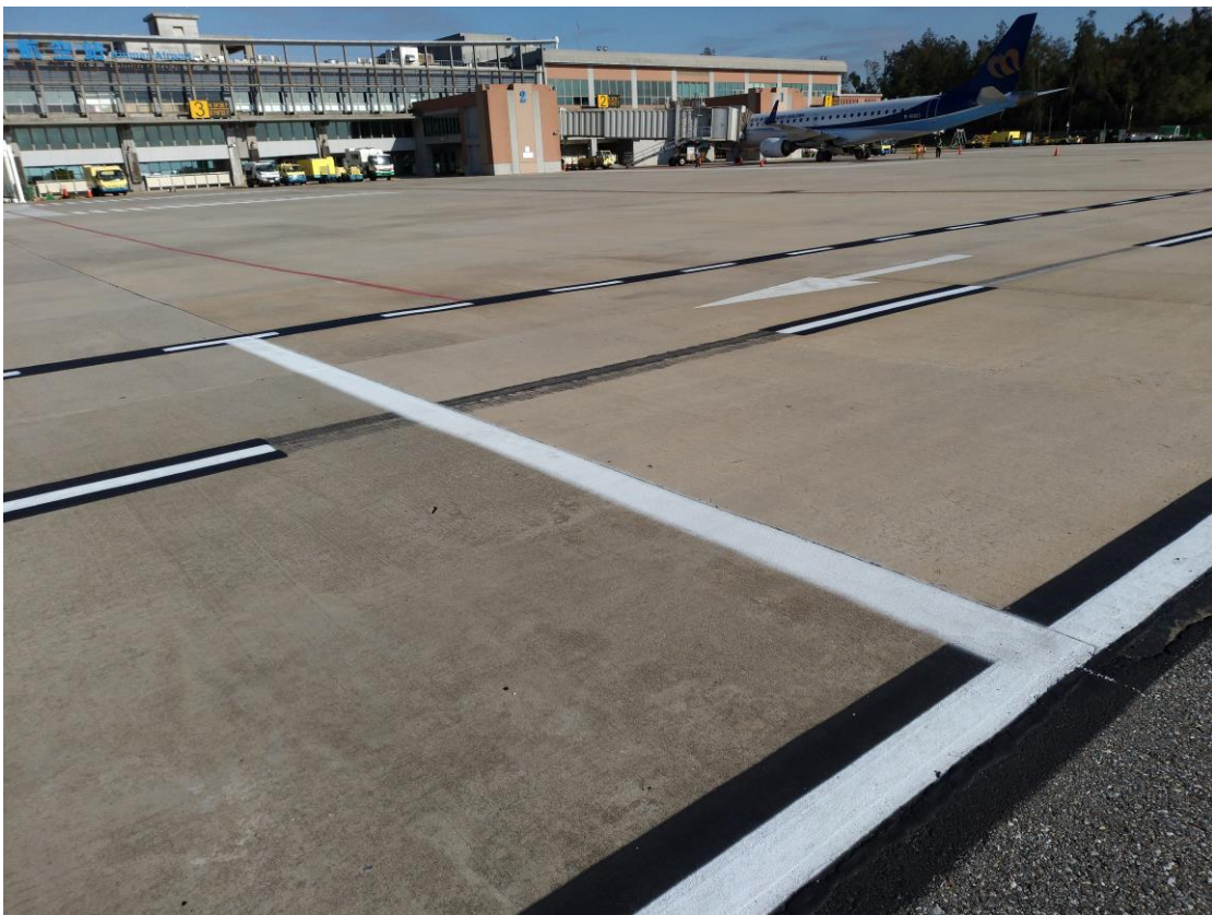
圖 2017-0038-4、3、4 號停機坪間加設停止線
