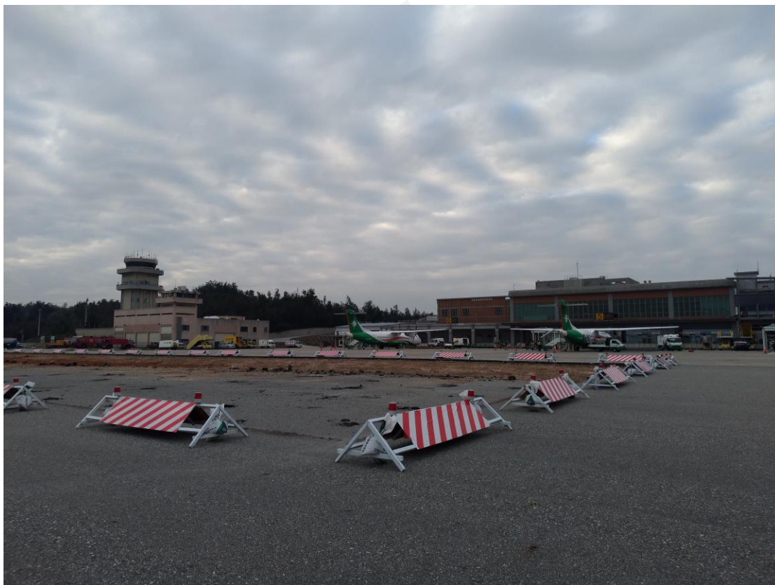
圖 2017-0037-1、5-6 號停機坪後方 N 滑行道施工區域
