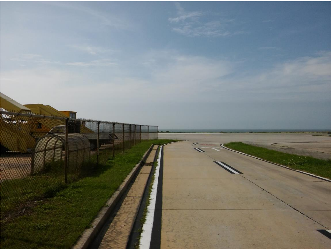
圖 2016-20-2、消防班旁交通道轉彎處交通道曲折狹窄
