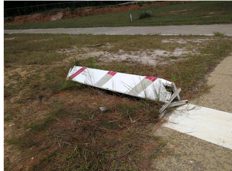
新待命點飛航管制區-警告指示牌毀損故障(改善前)圖-2
