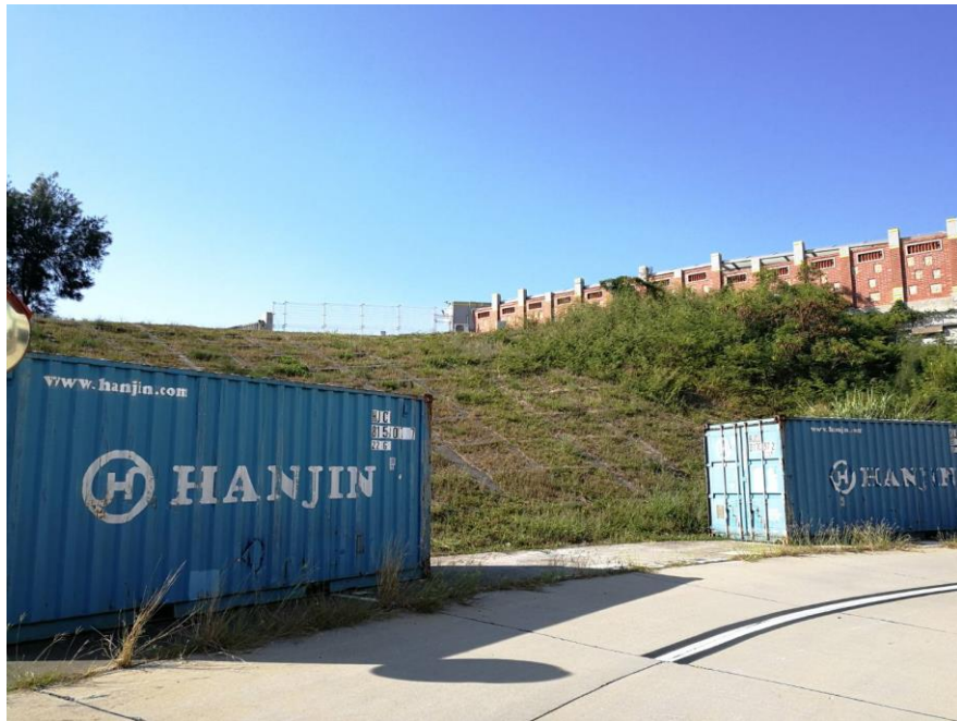
2 號管制門旁樹叢過茂建議檢修(改善前)圖-1、
